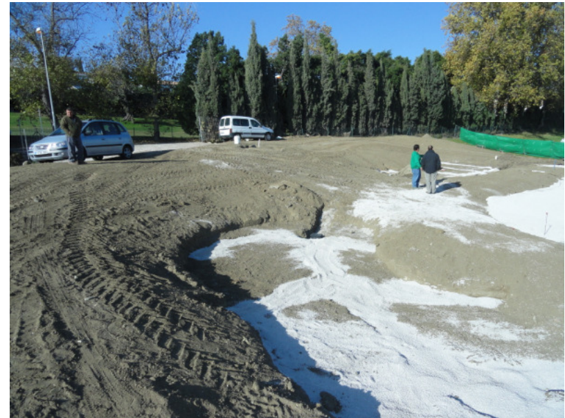
Drenajes y aportación de áridos / Drainage Sand and new soil
