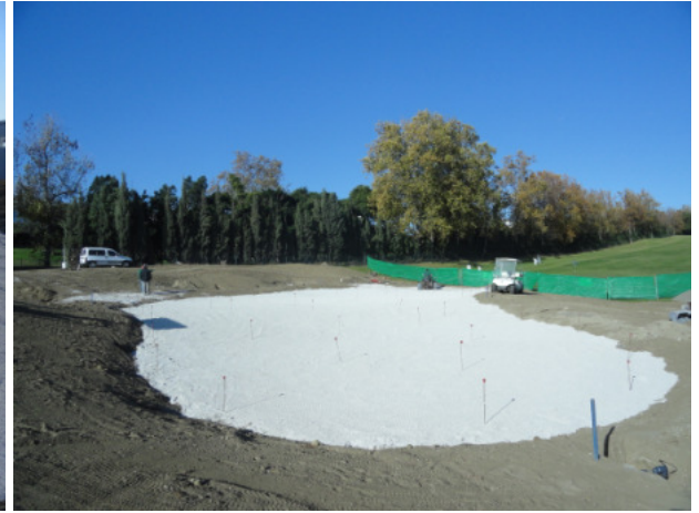
Drenajes y aportación de áridos / Drainage Sand and new soil
