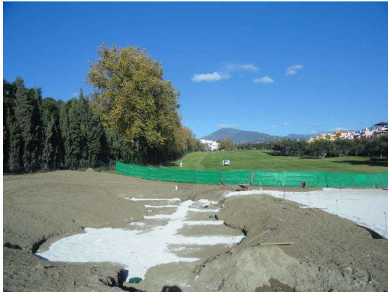
Drenajes y aportación de áridos / Drainage Sand and new soil
