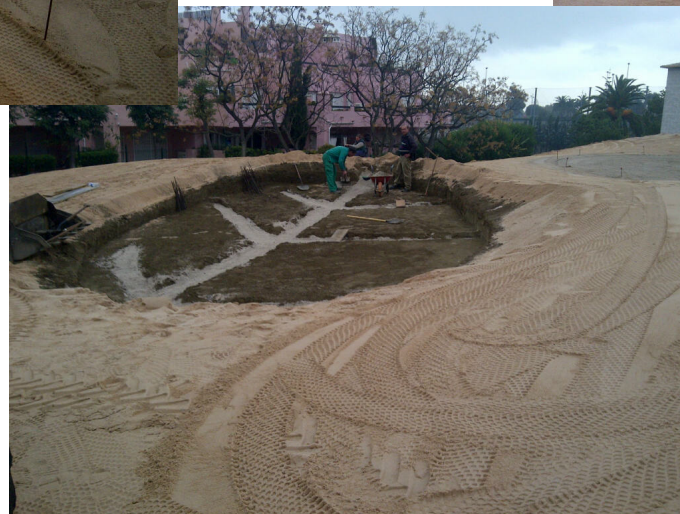
Detalle constructivo de los bunkers y aporte de arena en antegreen
